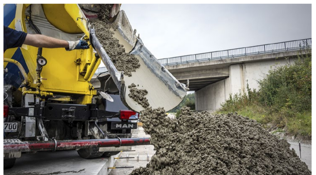
Ein Betonfahrermischer beim Abladen an einer Autobahnbaustelle. Das größte Autobahnprojekt war für Kocher-Jagst Beton bisher der Bau der Kochertalbrücke, bei dem rund 70.000 Kubikmeter Beton verbaut wurden.
